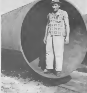
THIS MAN just fits in one of the four caissons driven on the pier at the south side. E HOMBER aki ta fiti den di un di e cuatro cajonnan mandá den banda di zuid di e pier.
